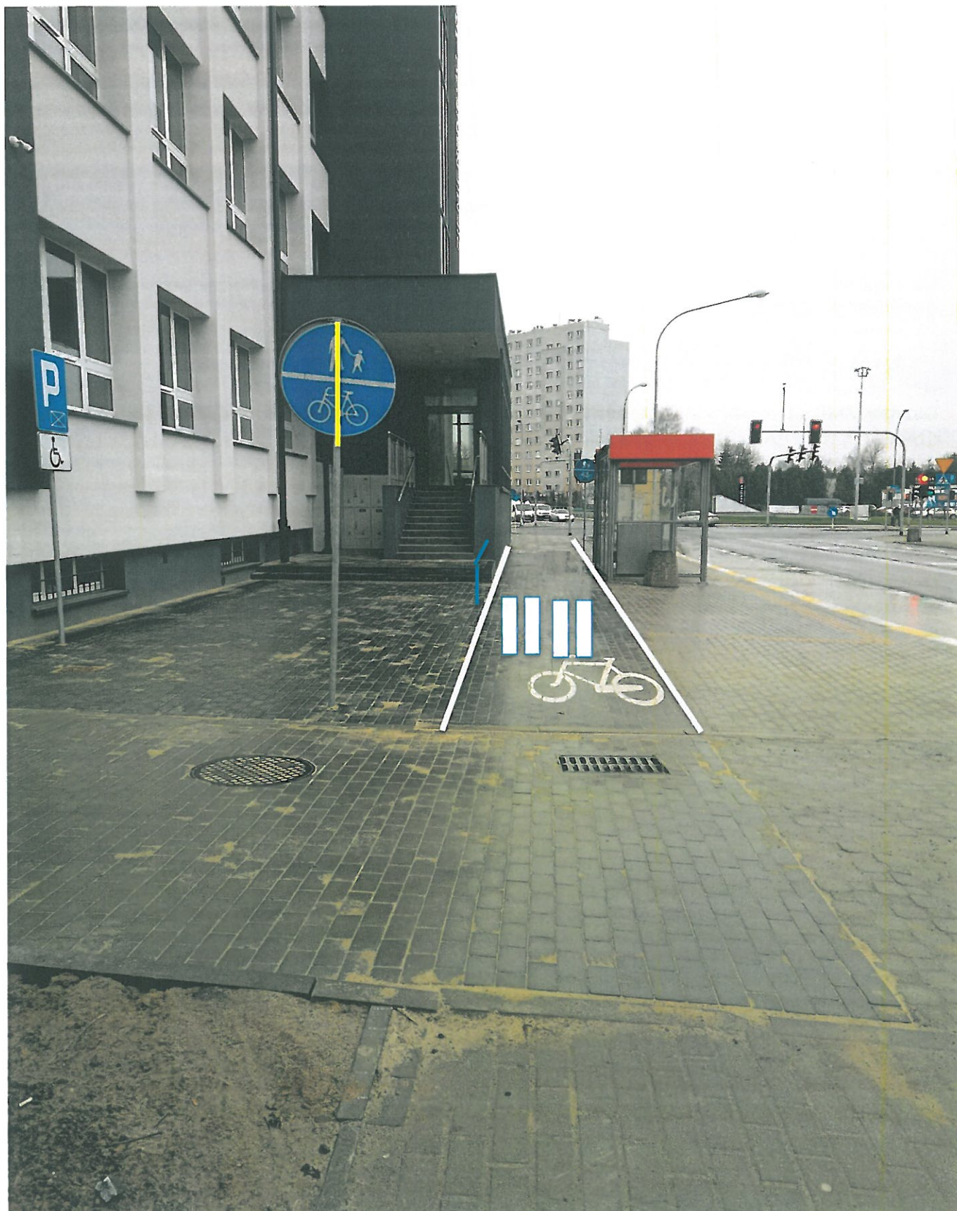
Rysunek 2. Zmieniony stan obecny, należy powrócić do znaków c13|c16 kreska pionowa, należy wmalować linie poziome, wymalować przejście, zamontować barierkę na schodach z budynku.
